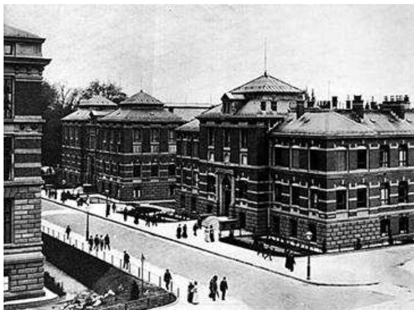
Fot. 3. Gmach Wydziału Elektrycznego Politechniki w Darmstadt (2 od prawej)
