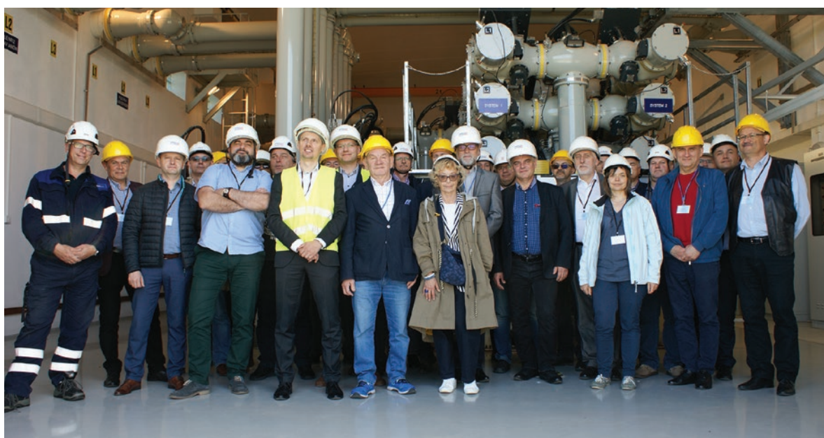
Rys. 3. Uczestnicy w rozdzielni 220 kV Ołtarzew
