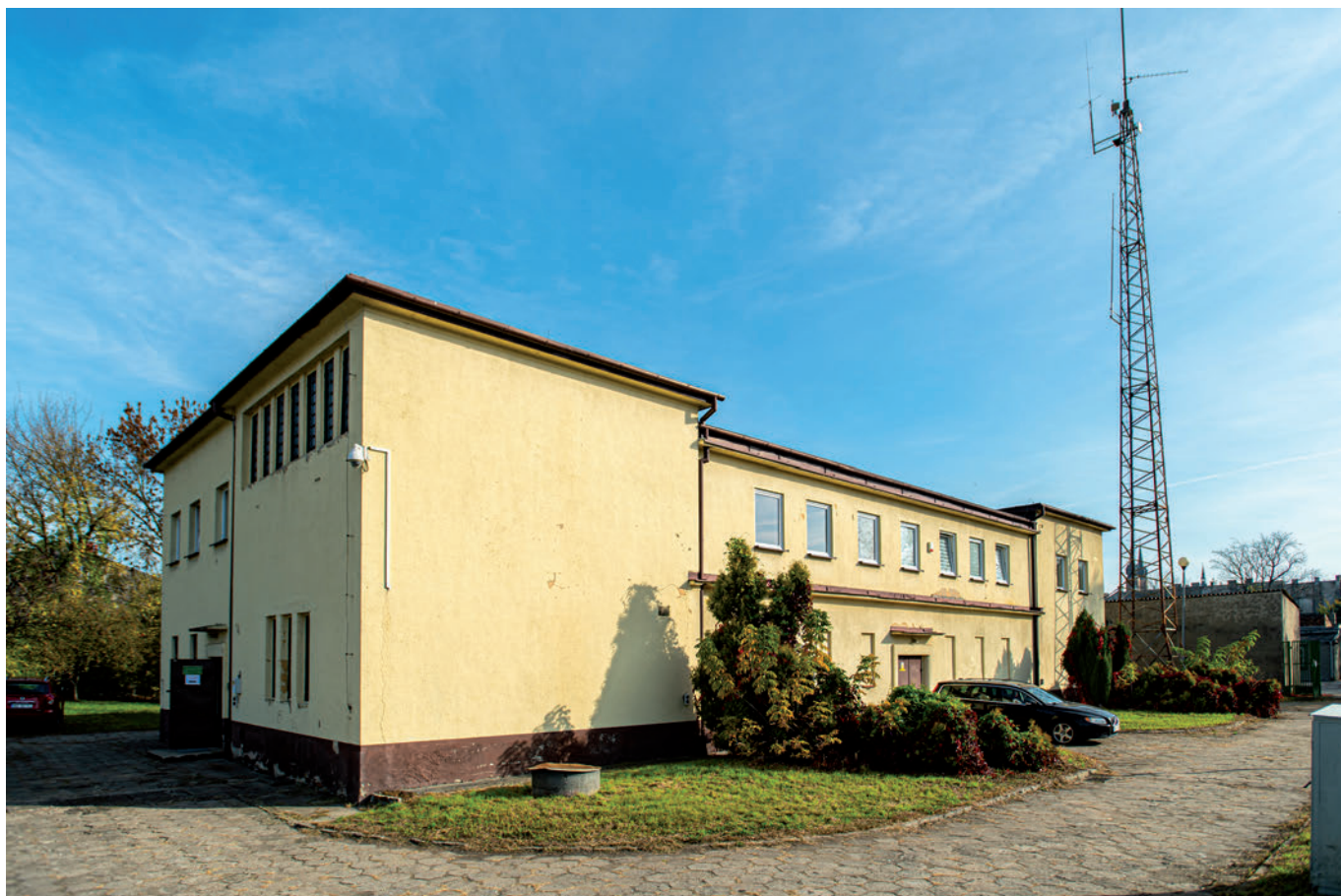
Miejsce muzeum elektrycznych urządzeń – budynek stacji GPZ 110/15 KV Radom Centralna
