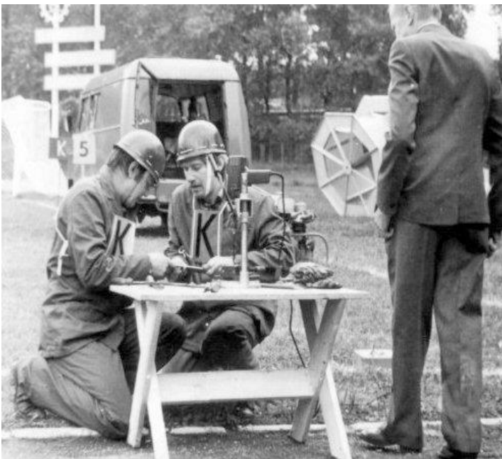
Brygada kablowa na stanowisku w pracach przygotowaw- czych do wykonania mufy lub głowicy kablowej.
