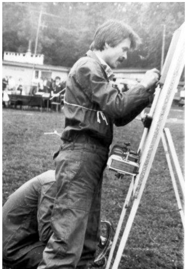
Brygada licznikowa montuje układ pomiarowy półpo- średni
