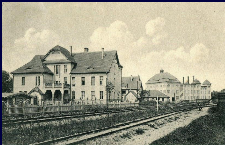
Elektrownia węglowa w Białogardzie
