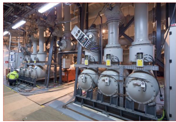
Rys. 11. Rozdzielnica gazowa 400 kV typu ELK-3 , zainstalowana na platformie DolWin-2 w Stacji Konwerterowej HVDC o mocy 924 MW , chroniąca autotransformator przed prądem zwarciovym, zasilanym od strony Stacji Kolektorowych HVAC.
