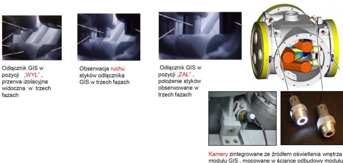
Rys. 20. Kadry z filmu : zdalna obserwacja ruchu styków głównych w module GIS typu ELK-04 z odłącznik-uziemnikiem w czasie rzeczywistym ! . Transmisja sygnału z wykorzystaniem światłowodów w kablach morskich na napięcia : 66 kV ; 220 kV lub 400 kV , na odległość do ...120 km , bez potrzeby wzmacniania sygnału !
