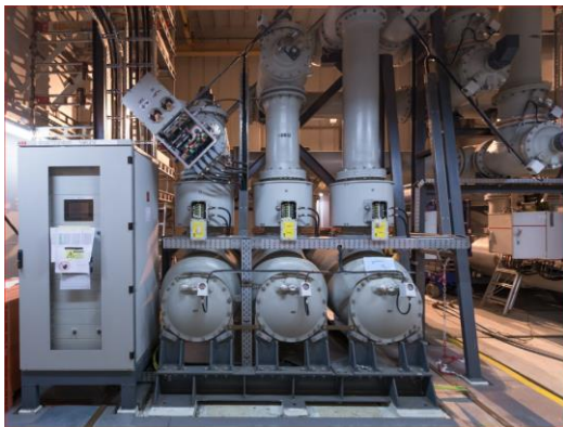
Rys. 11. Rozdzielnica gazowa 400 kV typu ELK-3 , zainstalowana na platformie DolWin-2 w Stacji Konwerterowej HVDC o mocy 924 MW , chroniąca autotransformator przed prądem zwarciovym, zasilanym od strony Stacji Kolektorowych HVAC.
