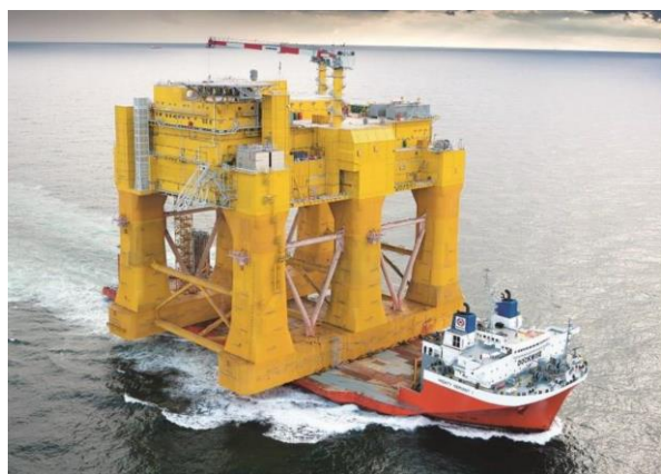
Rys. 10. Widok platformy DolWin-2 ze Stacją Konwerterową DC, z kompletem wyposażenia produkcyjnej ABB, o mocy 924 MW (masa platformy ok. 20.000 ton).
