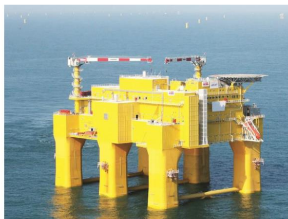
Rys. 10. Widok platformy DolWin-2 ze Stacją Konwerterową DC, z kompletem wyposażenia produkcyjnej ABB, o mocy 924 MW (masa platformy ok. 20.000 ton).
