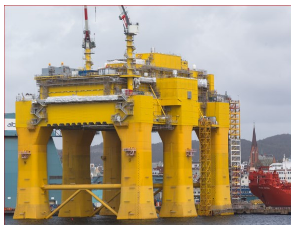
Rys. 10. Widok platformy DolWin-2 ze Stacją Konwerterową DC, z kompletem wyposażenia produkcji ABB, o mocy 924 MW (masa platformy ok. 20.000 ton).
