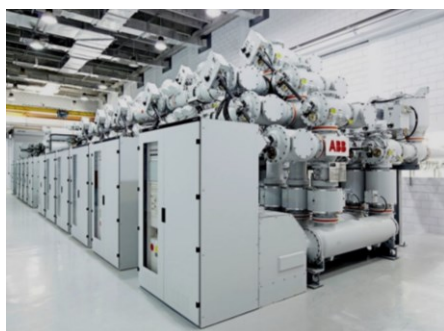
Rys. 7. Konfiguracja kompletnego pola rozdzielnic 220 kV w izolacji gazowej Typu ELK-14/300 stosowana w morskich Stacjach Kolektorowych prądu przemiennego HVAC dużej mocy.
