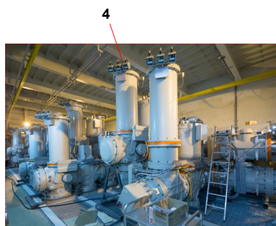
Rys. 8. Przykład wielopolowej rozdzielnicy w izolacji gazowej typu ELK-04 , zainstalowanej w morskiej Stacji Kolektorowej HVAC wielkiej mocy po stronie 66 kV (prąd szyn zbiorczych 4000 A prąd wyłączalny 63 kA).
