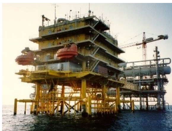
Rys. 3. Widok platform ze stacjami kolektorowymi HVAC , 66 kV/132 -220 kV
