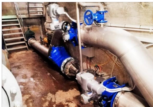
Fot. 3. Sposób zabudowy hydrozespołu w Wapienicy
