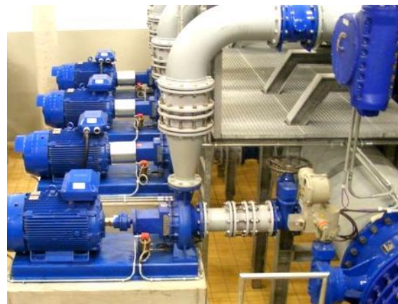
Rys.4 Turbiny pompowe w układzie równoległym
