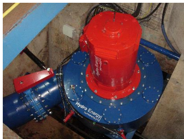
Rys. 5 Hydrozespół w MEW Dobromierz.
