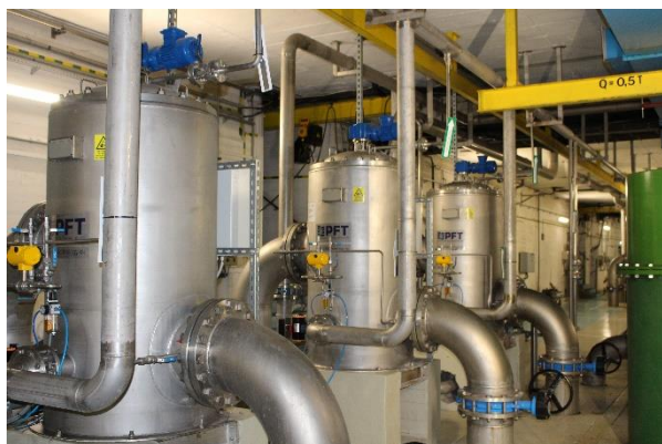
Zdj. 1 Filtry samoczyszczące DN300 wody chłodzącej wyprodukowane przez PFTechnology
