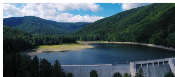
Fot.1. Widok zapory wodnej i zbiornika retencyjnego w Wapienicy. Mat. arch. AQUA S.A
