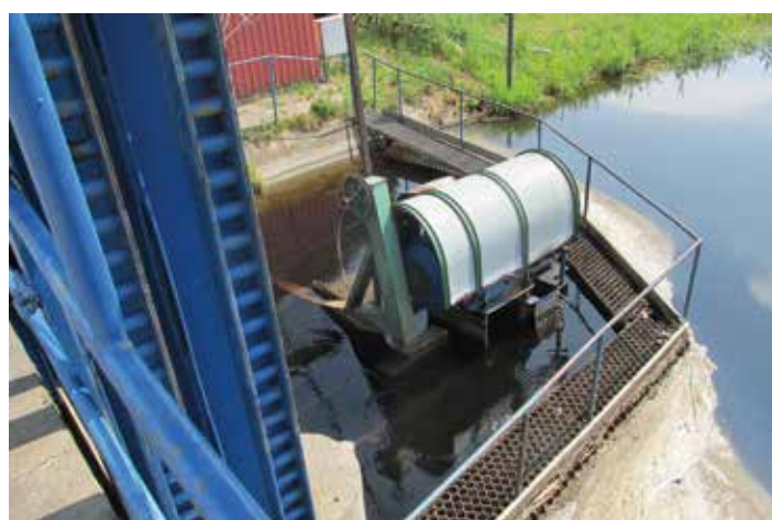
Elektrownia Wodna Charbice Dolne. Foto: F. Mosiński
