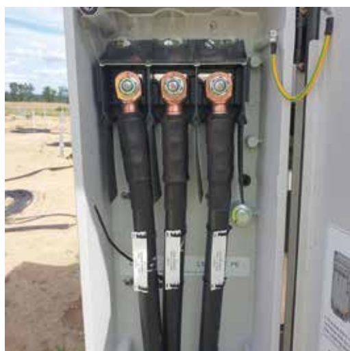
Rys. 6. Przykład zastosowania końcówek KMA na farmie fotowoltaicznej
