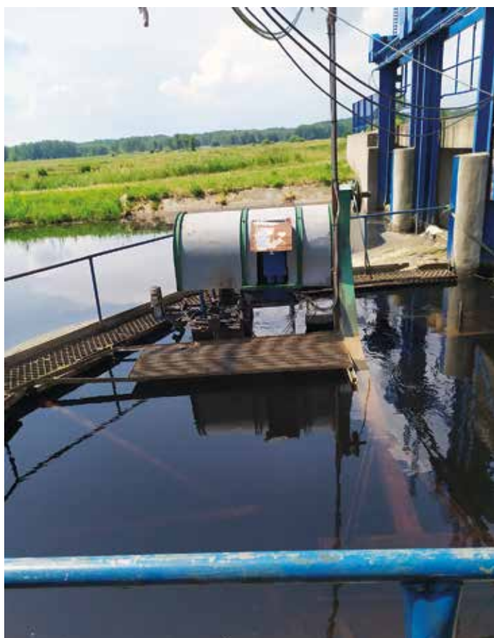
Elektrownia Wodna Charbice Dolne. Foto: M. Höffner
