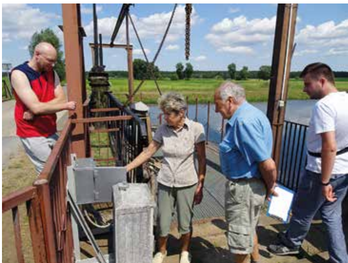
Elektrownia Wodna Małyń. Foto: S. Burda
