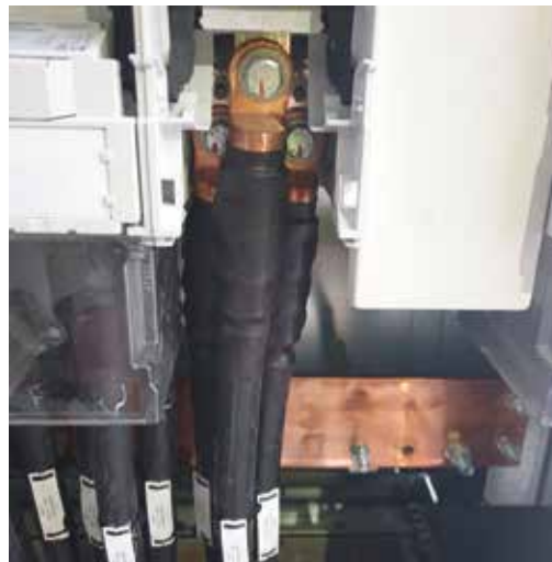
Rys. 6. Przykład zastosowania końcówek KMA na farmie fotowoltaicznej
