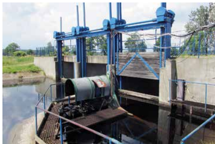
Elektrownia Wodna Charbice Dolne. Foto: F. Mosiński
