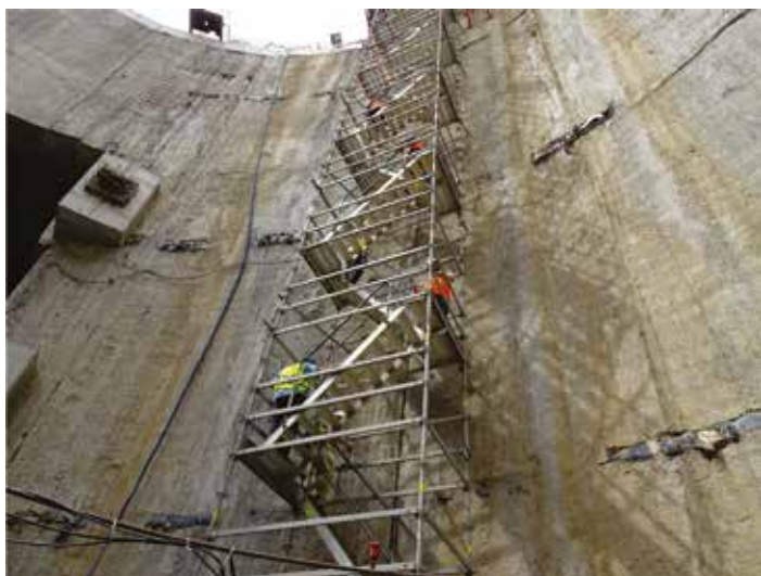
Rys. 4. Zejście do tunelu w komorze wschodniej (fot. S. Burda)
