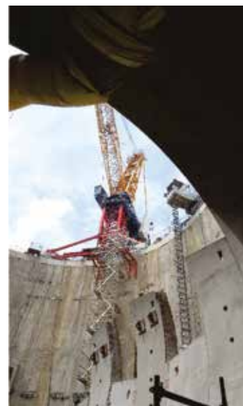
Rys. 5. Dźwig nad komorą wschodnią (fot. A. Gawrysiak)
