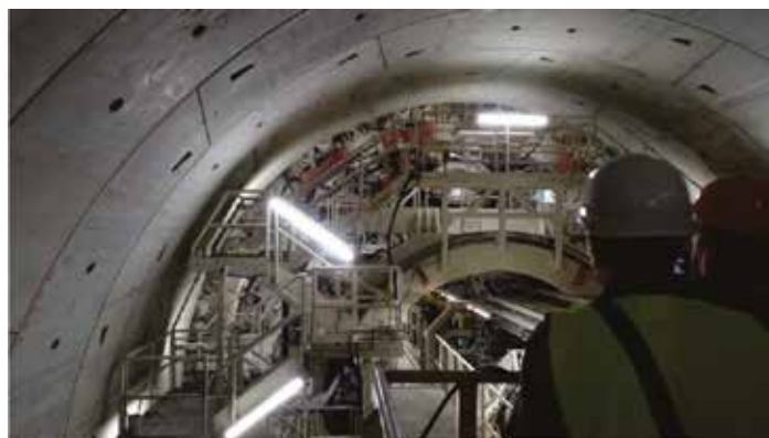
Rys. 6. TBM Katarzyna od środka (fot. A. Gawrysiak)
