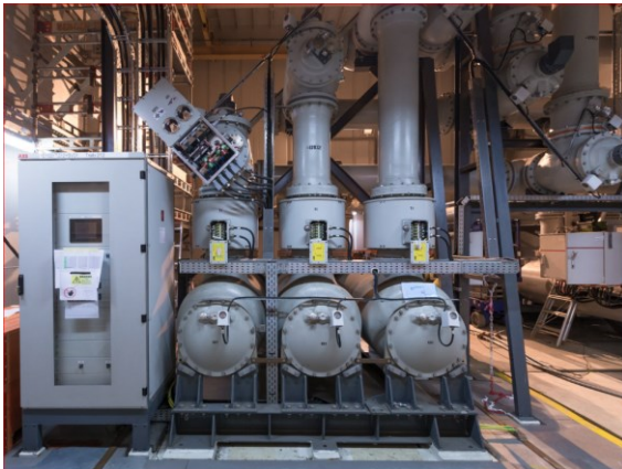
Rys. 11. Rozdzielnica gazowa 400kV typu ELK-3 zainstalowana na platformie DolWin-2 w Stacji Konwerterowej DC o mocy 924 MW , po stronie zasilania autotransformatora zintegrowanego z zespołem konwerterów.
