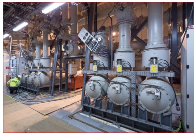
Rys. 11. Rozdzielnica gazowa 400kV typu ELK-3 zainstalowana na platformie DolWin-2 w Stacji Konwerterowej DC o mocy 924 MW , po stronie zasilania autotransformatora zintegrowanego z zespołem konwerterów.
