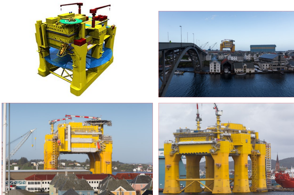
Rys. 10. Widok platformy DolWin-2 ze Stacją Konwerterową DC, z kompletem wyposażenia produkcji ABB , o mocy 924 MW (masa platformy ok. 20.000 ton).
