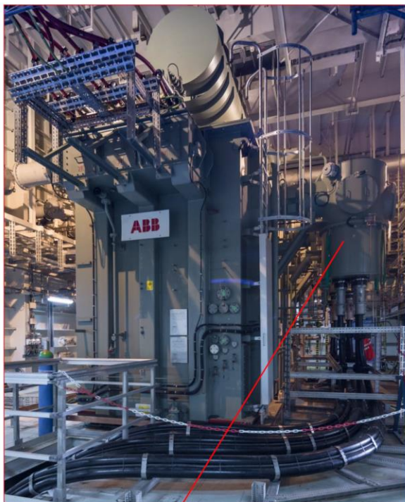
RYS. 3. "Offshorowe" Transformatory Mocy (OTM) w Morskiej Stacji Kolektorowej (MSK) 66 kV/220 kV [1].
