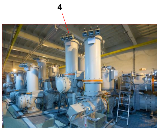
RYS. 7. Przykład wielopolowej rozdzielniczy w izolacji gazowej typu ELK-04, zainstalowanej w morskiej Stacji Kolektorowej HVAC wielkiej mocy po stronie 66 kV (prąd szyn zbiorczych 4000 A prąd wyłączalny 63 kA) [1]
