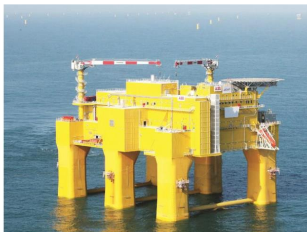
RYS. 1. Widok platformy DolWin-2 ze Stacją Konwerterową HVDC, z kompletem wyposażenia produkcji ABB o mocy 924 MW (masa platformy ok. 20.000 ton) [1].
