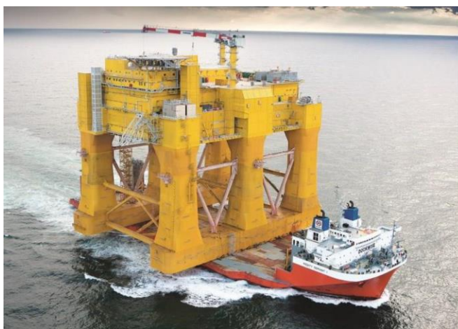
RYS. 1. Widok platformy DolWin-2 ze Stacją Konwerterową HVDC, z kompletem wyposażenia produkcji ABB o mocy 924 MW (masa platformy ok. 20.000 ton) [1].
