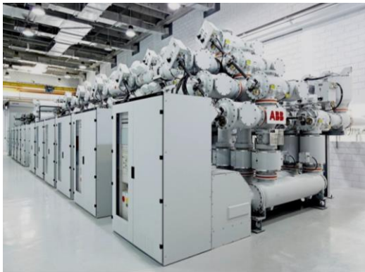
RYS. 5. Konfiguracja kompletnego pola rozdzielnic 220 kV w izolacji gazowej Typu ELK-14/300 stosowana w Morskich Stacjach Kolektorowych (MSK) prądu przemiennego HVAC dużej mocy.
