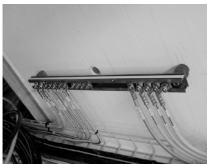
Rys. 7. Przykładowe rozwiązania konstrukcyjne szyn wyrównawczych
