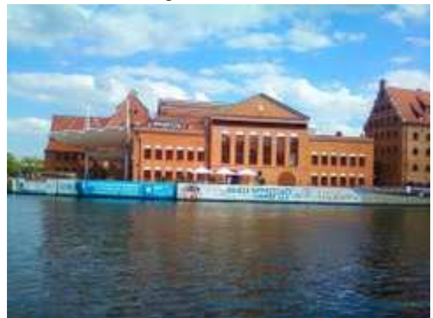
Fot. 2. Była Elektrociepłownia Ołowianka. www.filharmonia.gda.pl
