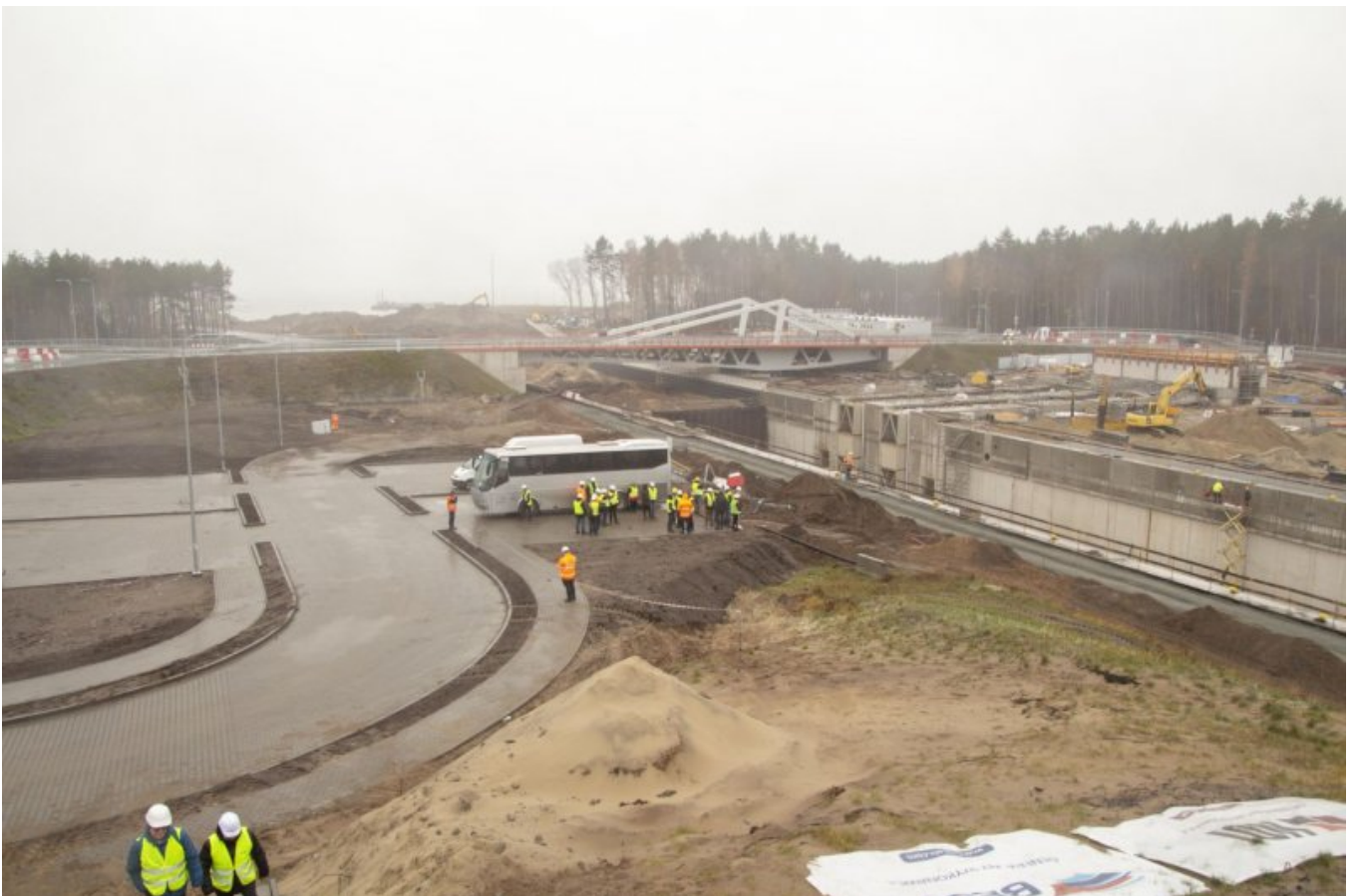
Fot. 2. Widok na kanał i most południowy im. Jerzego Wilka
