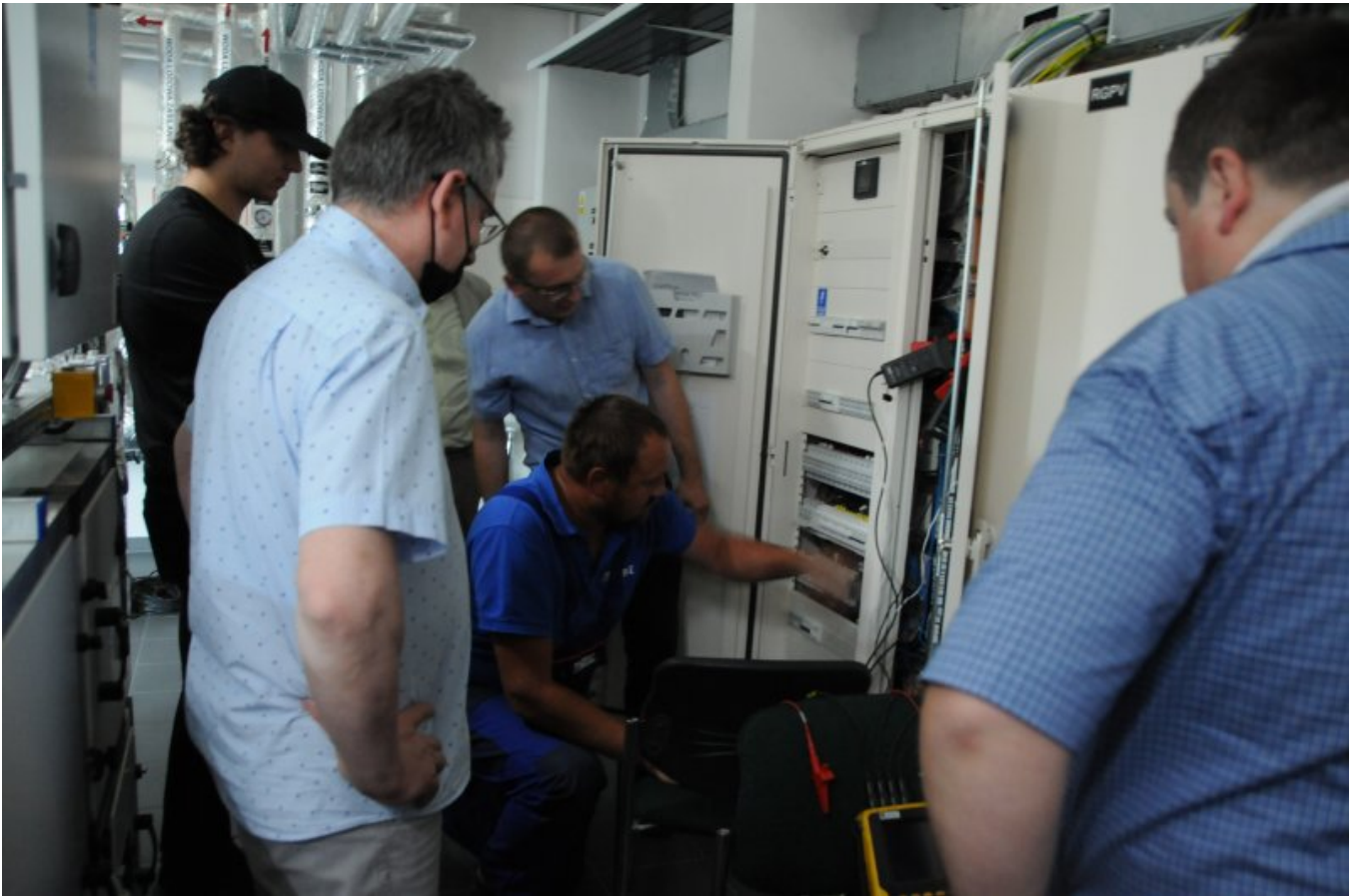
Praktyczne wykonywanie pomiarów na rozdzielnicy RG w siedzibie PDK OIIB w Rzeszowie.
