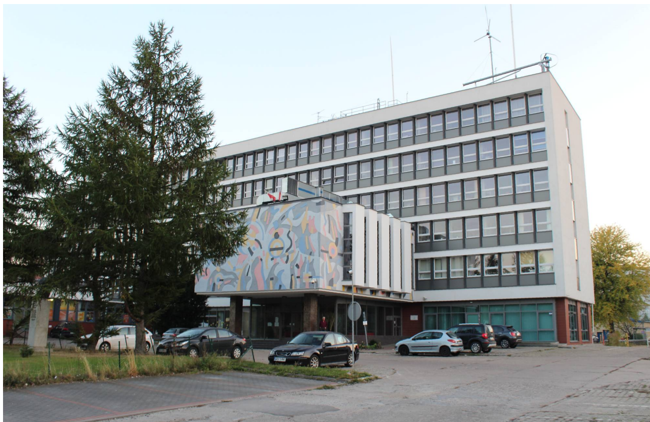
Budynek Instytutu Maszyn Przepływowych PAN w Gdańsku
