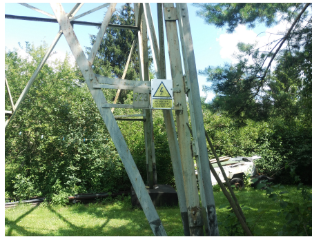
Z1. Fragment słupa linii 220 kV, kiedyś linii 150 kV, stojący na prywatnej posesji we wsi Złotokłos k. Warszawy.
