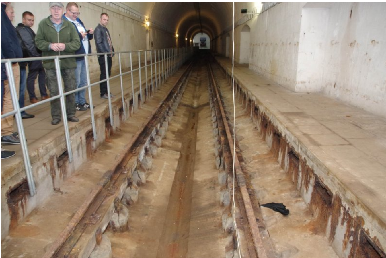
Zwiedzanie bunkra kolejowego w Konewce
