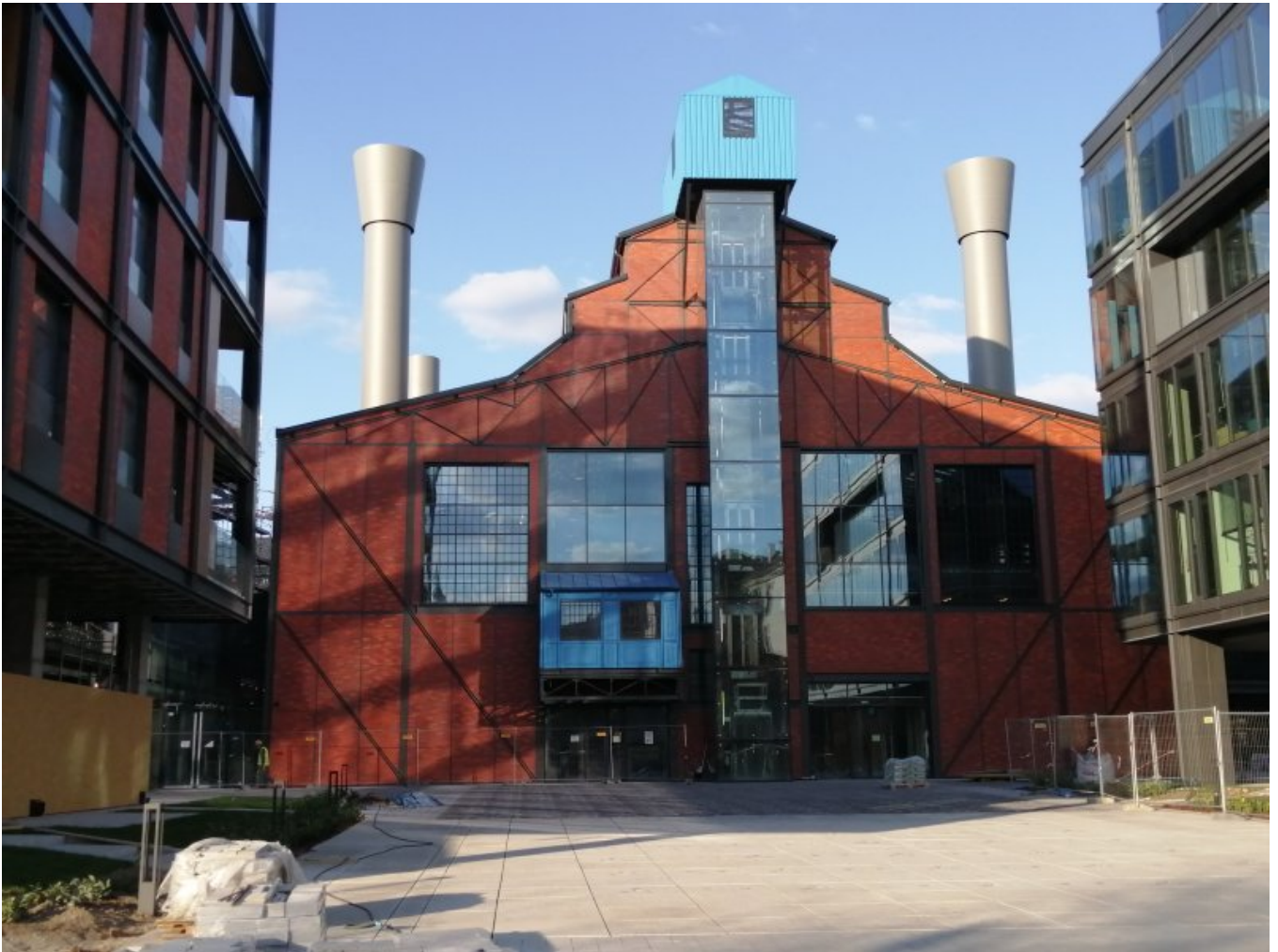
Zrewitalizowany budynek kotłowy – widok z kwietnia 2020 r. (fot. J. Nowicki)
