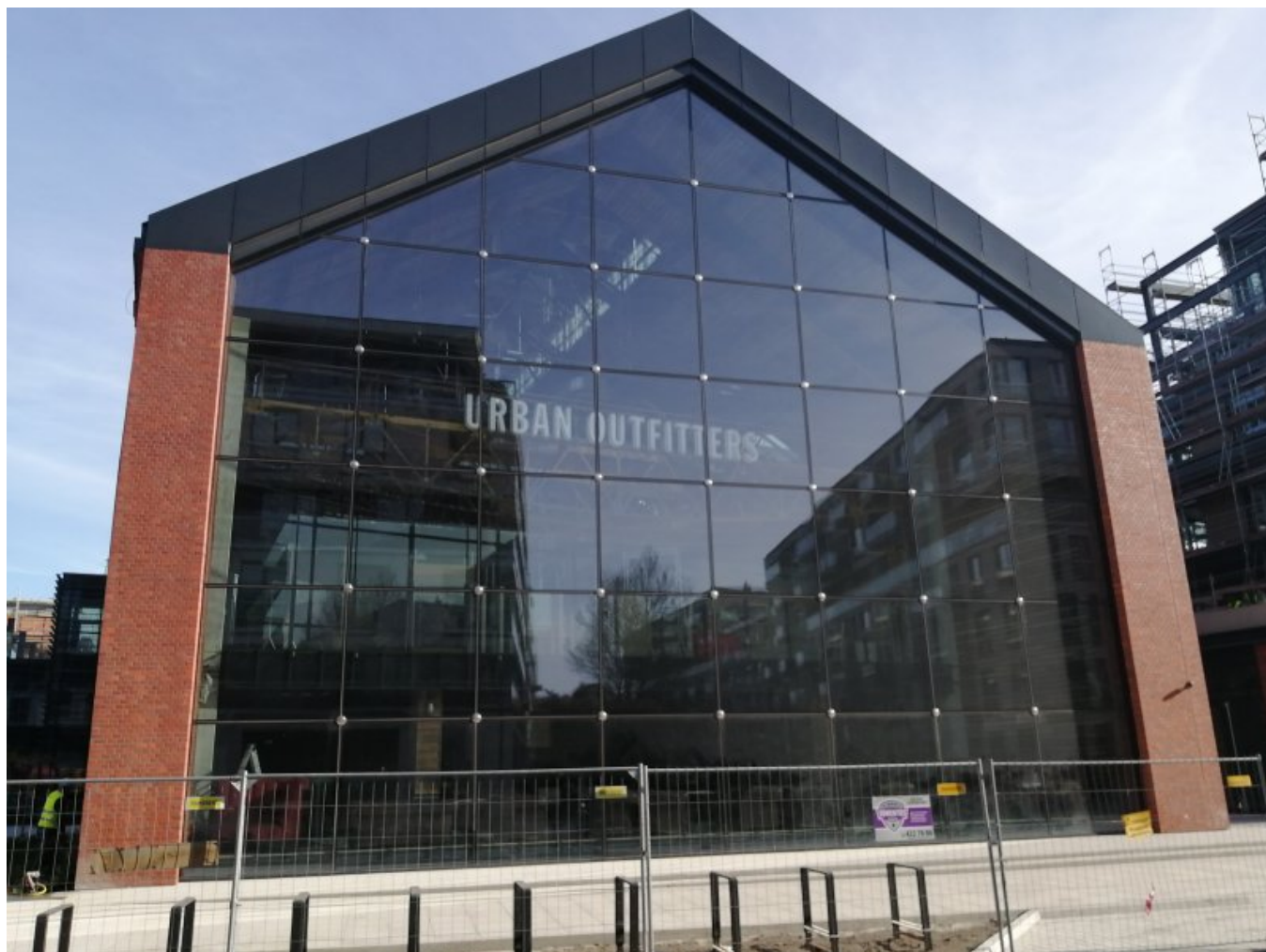
Przeszklona ściana szczytowa dawnego budynku maszynowego. Widoczny oryginalny dźwig suwnicowy – widok z kwietnia 2020 r. (fot. J. Nowicki)
