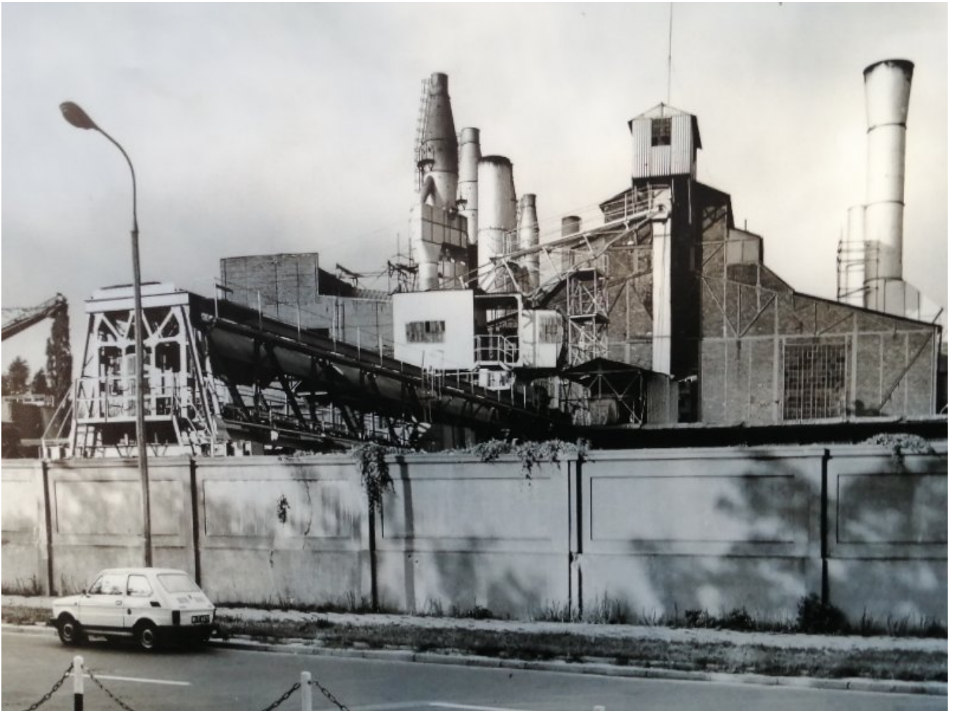
Lata 1970-te. Widoczny zewnętrzny pomost instalacji nawęglania kotłów
