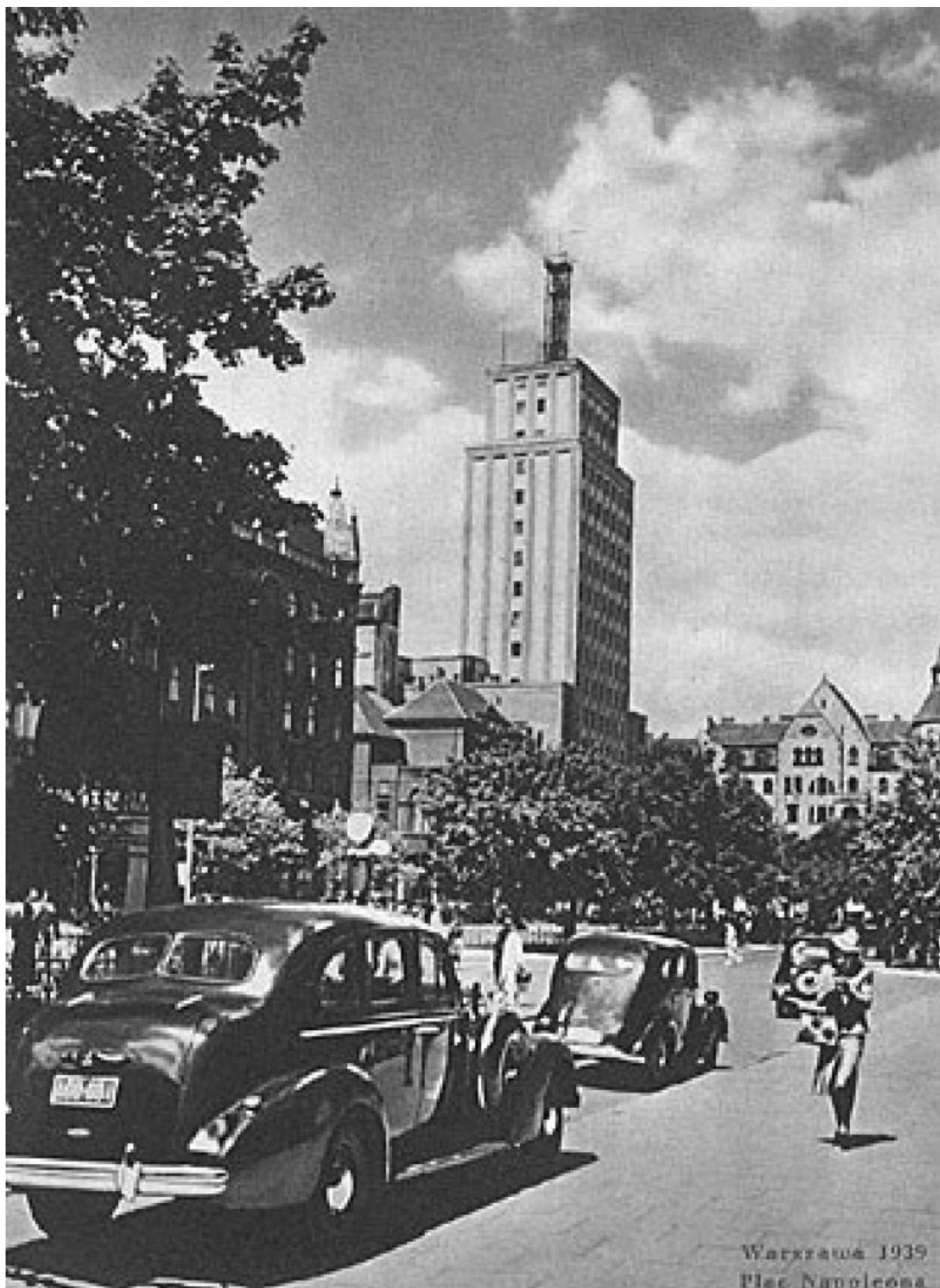
Budynek Prudential w Warszawie z masztem nadawczym Eksperymentalnej Stacji Telewizyjnej
