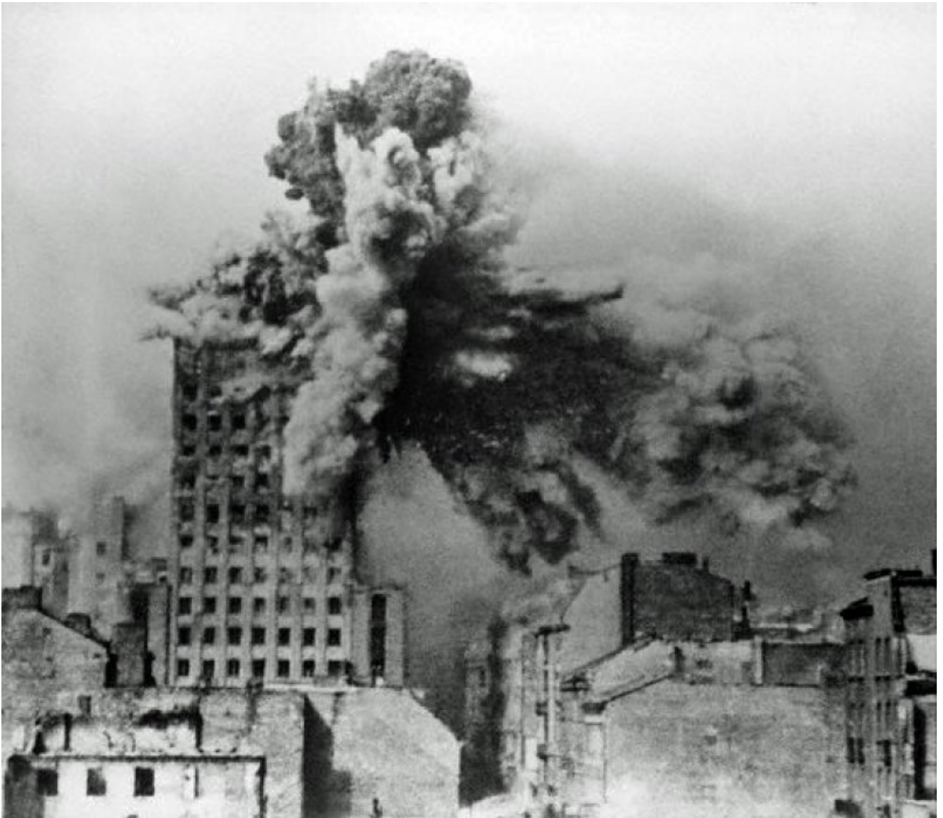
Wybuch pocisku kaliber 600 mm na szczycie Prudentialu – 28 sierpnia 1944 r. Prawdopodobnie eksplozja ta zmiotła z dachu budynku maszt nadawczy Eksperymentalnej Stacji Telewizyjnej
