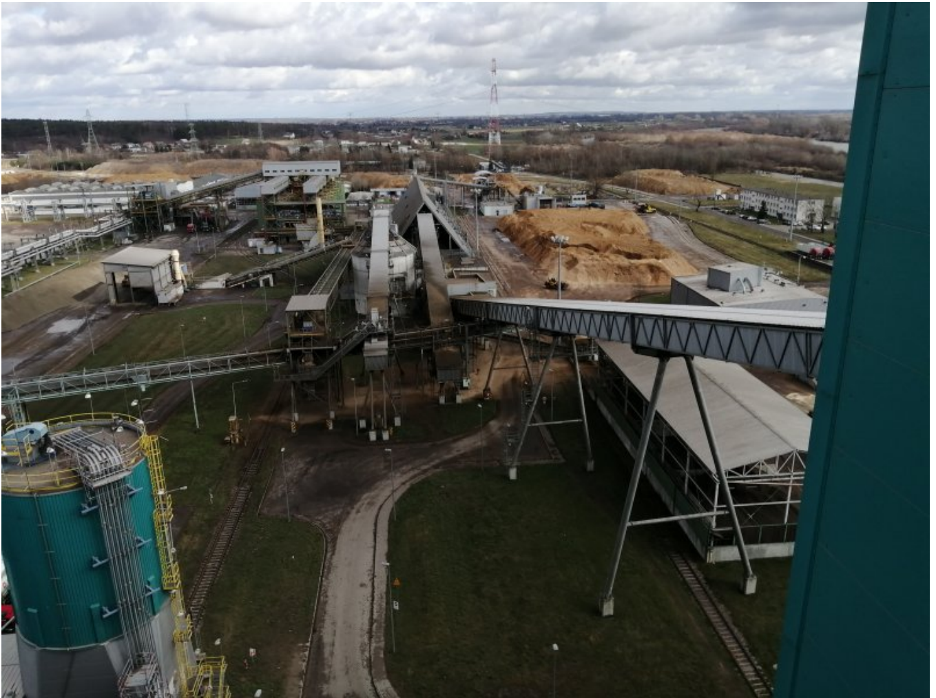
Zaplecze Zielonego Bloku Elektrowni Połaniec. Z prawej strony taśmociąg dostarczający gotowe paliwo do kotła fluidalnego. W tle stacje przygotowania biomasy pochodzącej z odpadów z produkcji rolniczej i leśnej oraz składowiska gotowego bio-paliwa
