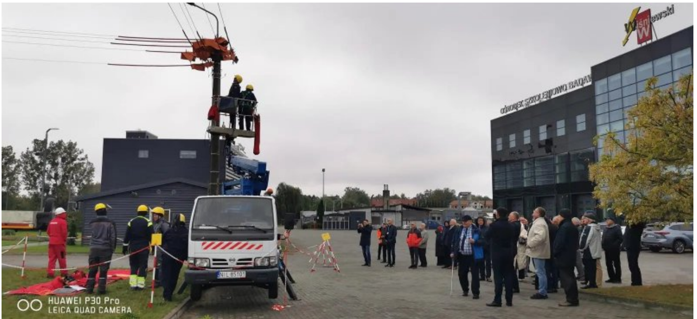
Pokaz szkolenia z prac w technologii ppn na linii napowietrznej 0,4 kV
