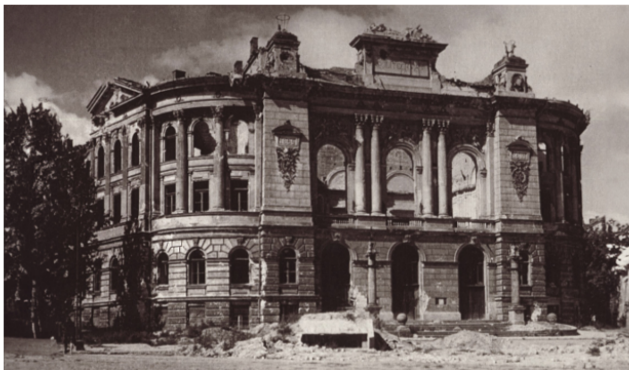
Budynek Główny Politechniki Warszawskiej, wrzesień 1944 roku
