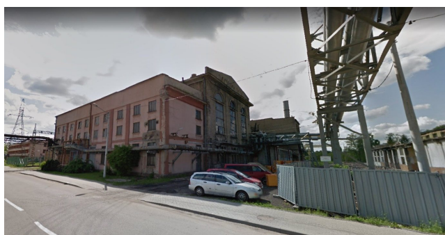
Zdjęcie 9. Ulica Ignacego Mościckiego w Skarżysku-Kamiennej, widok na elektrociepłownię Zakładów Metalowych Mesko S.A. [14]
