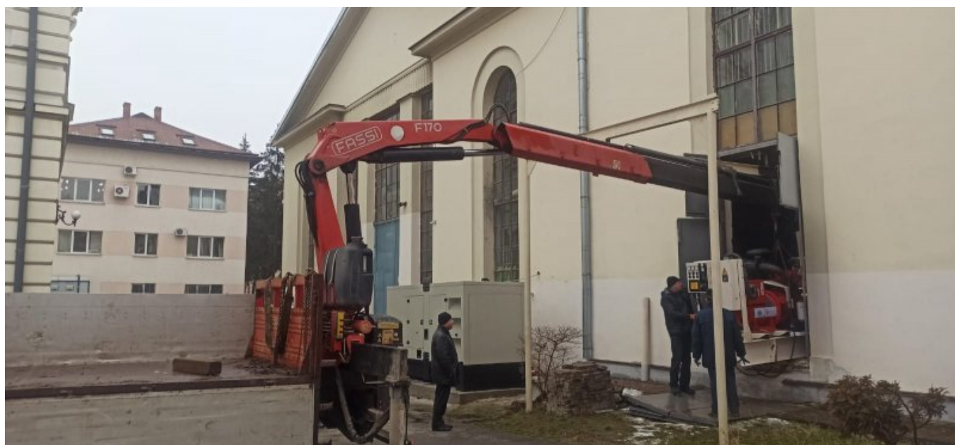
Politechnika Lwowska - montaż w ciepłowni agregatu prądotwórczego o mocy 250 kVA
