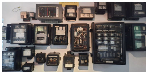
Fot.16 Elektroenergetyczna aparatura zabezpieczeniowa (autor Andrzej Jutrzenka)
