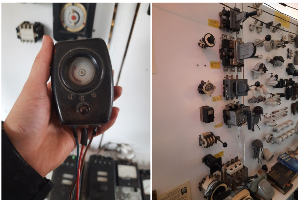
Fot.15 Kontrola podłączenia faz i rozłączniki (autor Andrzej Jutrzenka)
