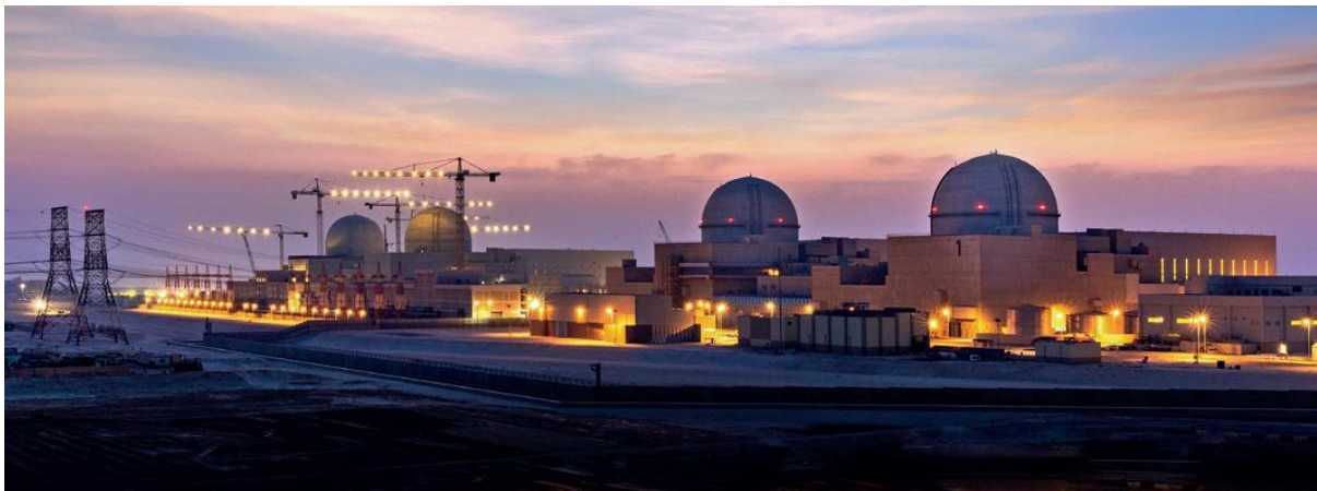
Rys. 1. Elektrownia Jądrowa Barakah w wieczornej scenerii. Z prawej widoczne są już uruchomione Bloki 1 i 2 (fot. ENEC)
