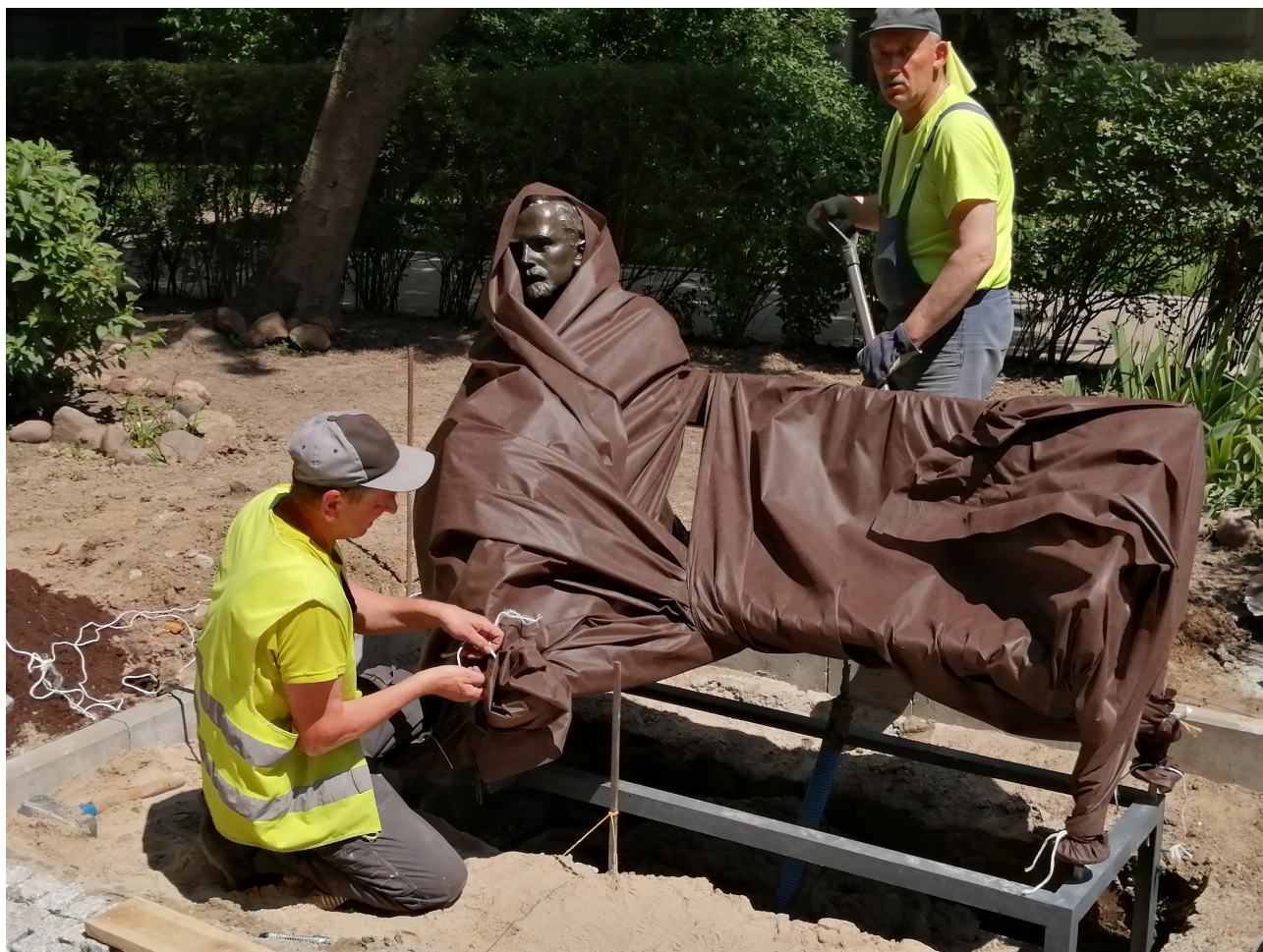
Przygotowania do betonowania fundamentu pomnika M. Pożaryskiego.
