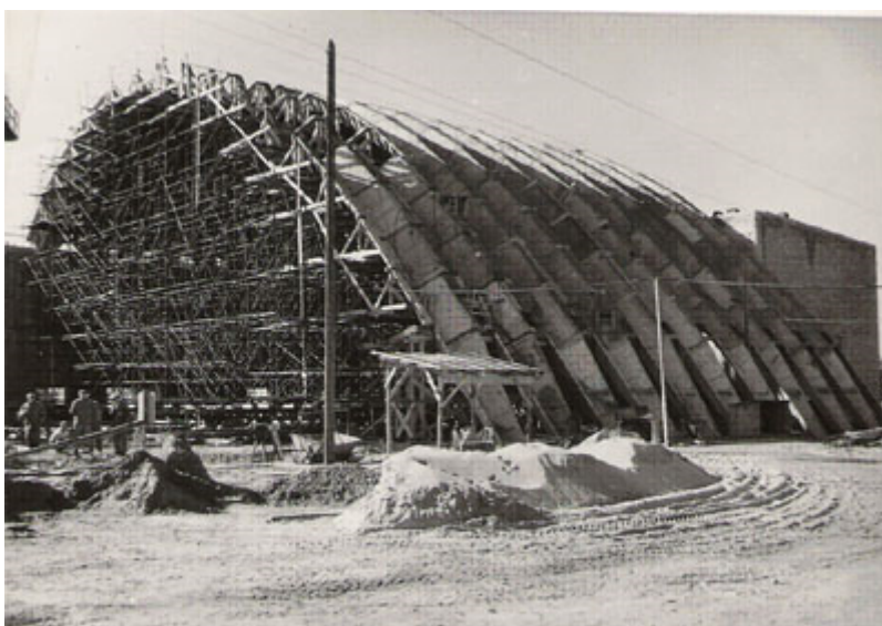
Budowa hali generatorów zwarciozni Instytutu Elektrotechniki w Warszawie-Międzylesiu (fot.
