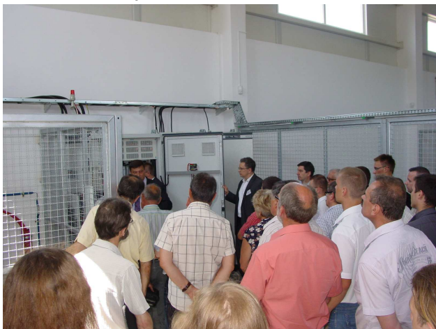
Fot.1 Uczestnicy Konferencji zapoznają się z jedną z rozdzielnic w budynku laboratoryjnym Wydziału Elektrycznego Politechniki Białostockiej.
